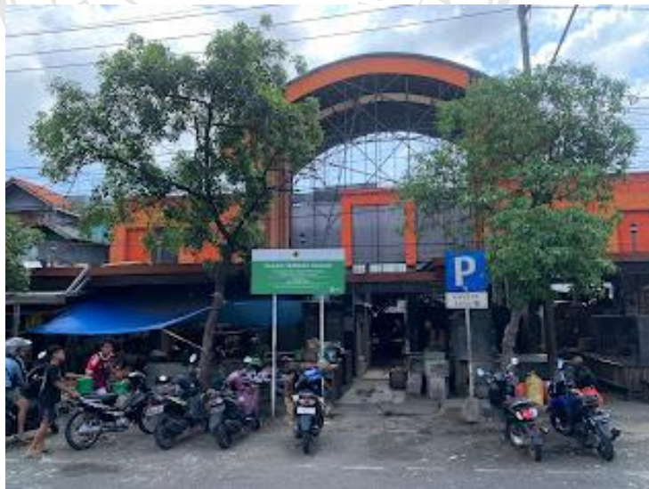
Gambar; Kondisi Fisik Pasar
