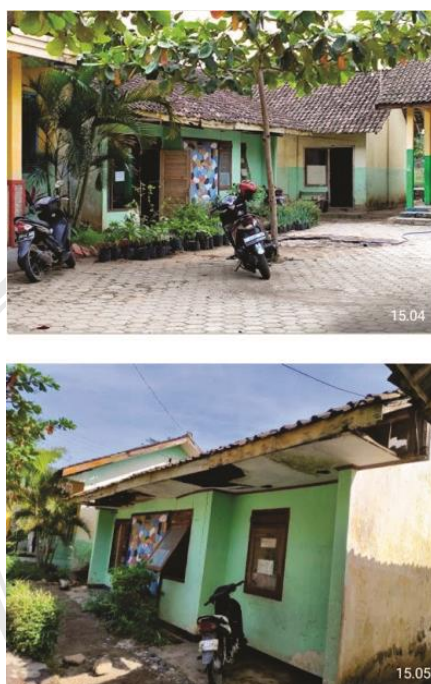
Gambar 3. 5 Gedung yang tidak dipakai
