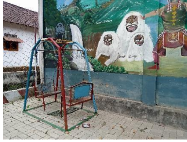
Gambar 1.4: Salah satu fasilitas yang rusak diakibatkan oleh siswa Madrasah Diniyah Takmiliah Awaliyah Baitur Rahman Sumber : Data Pribadi
