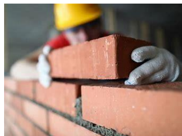
Gambar 4.11: Pemasangan batu bata
