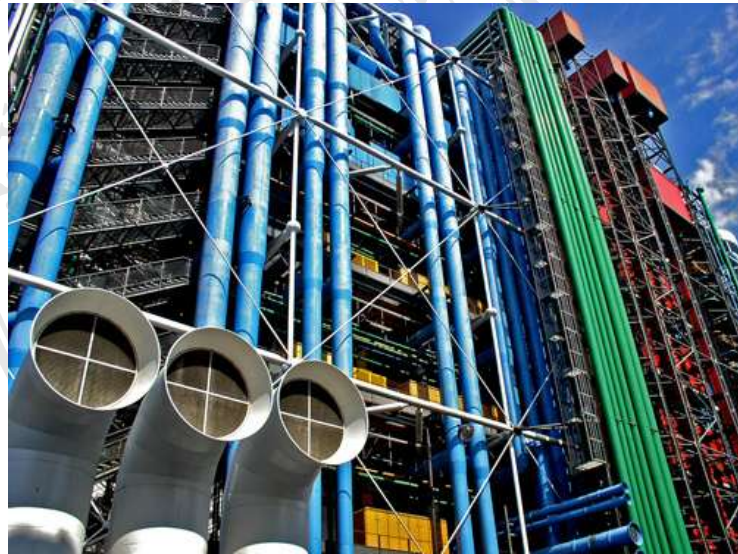
Gambar 2. 3 Susunan Pipa-Pipa Yang Berfungsi Sebagai Bagian Dari Struktur
