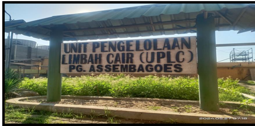
Instalasi pengolahan Limbah cair Pabrik Gula Assembagoes
